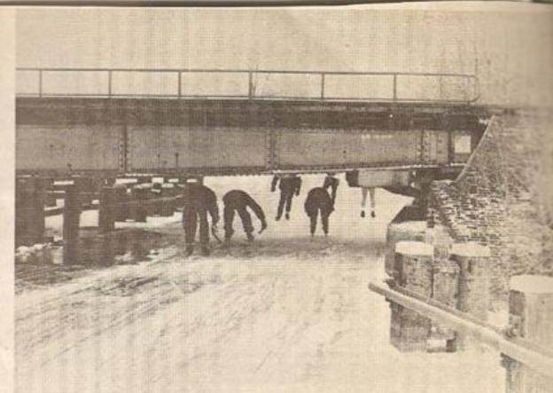
Bij de spoorbrug in Bedum moest even gebukt worden om vlekkeloos te kunnen passeren.
